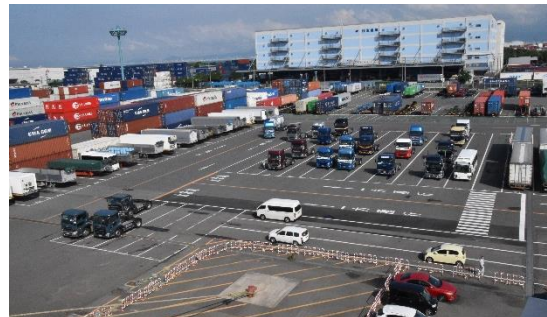
大阪南港のさんふらわあフェリーターミナルです。
